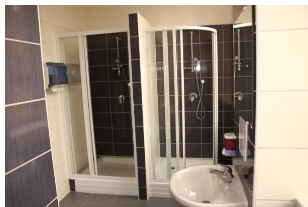
Zrekonstruovaná sociální zařízení v bloku E
