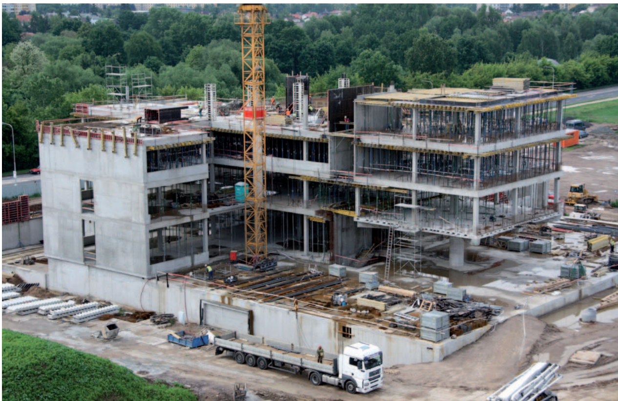
Stavba první budovy Kampusu UK v Hradci Králové – červen 2013 Construction of the First Building of the Campus of Charles University in Hradec Králové – June 2013
