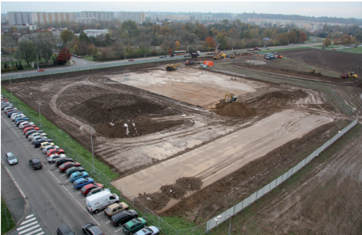
Stavba první budovy Kampusu UK v Hradci Králové – leden 2013 Construction of the First Building of the Campus of Charles University in Hradec Králové – January 2013
