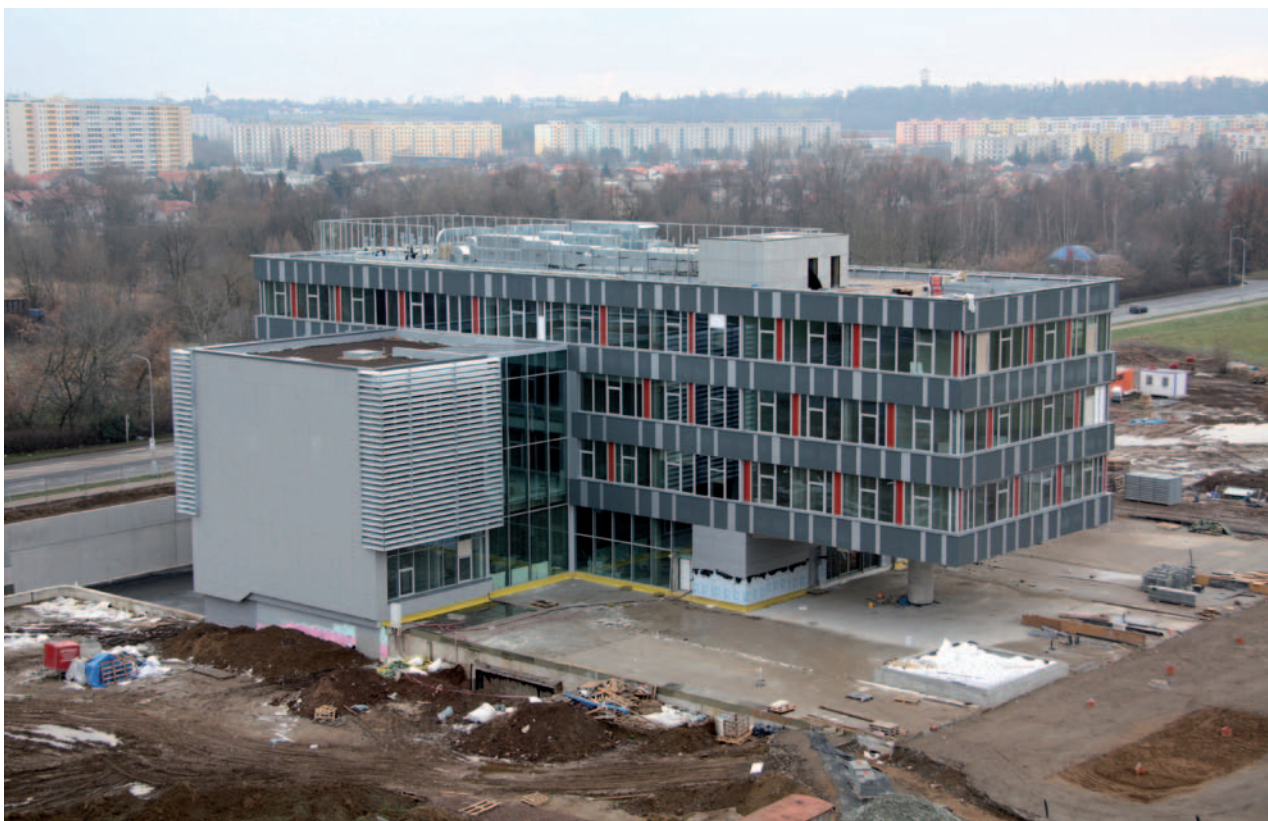
Stavba první budovy Kampusu UK v Hradci Králové – prosinec 2013
