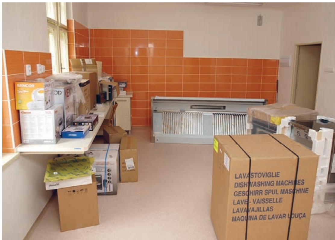
Kuchyně po rekonstrukci, v průběhu vybavování
