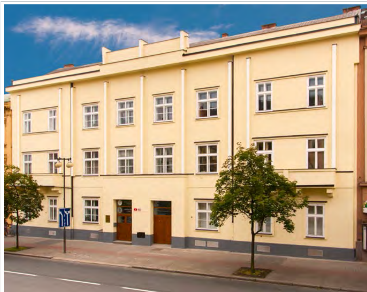
Budova děkanátu, Husova 3, Plzeň.
