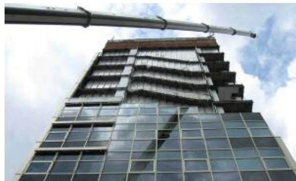
MFF – rekonstrukce fasády katedrového objektu v Troji
