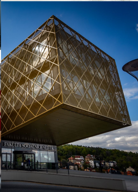
Zrekonstruovaná budova FSV UK v Jinonicích ↑
